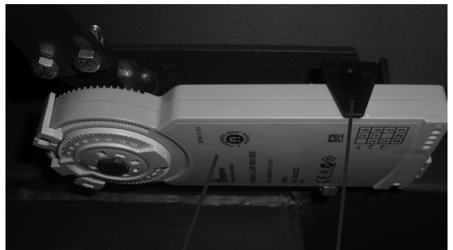
Moteur de commande Patte de maintien moteur
