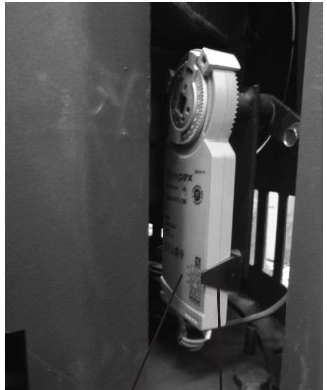
Servomotor Klembeugel van kunststof
