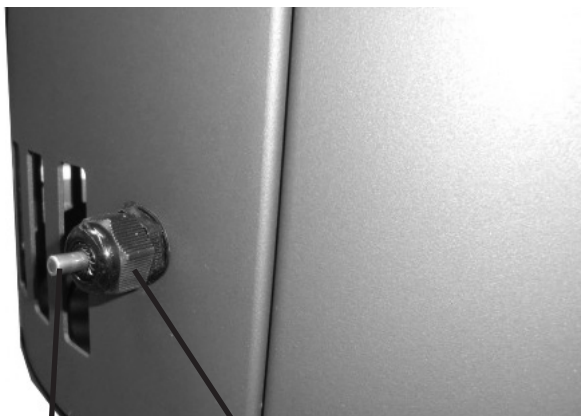
Sonde de température ambiante Ecrou-raccord
