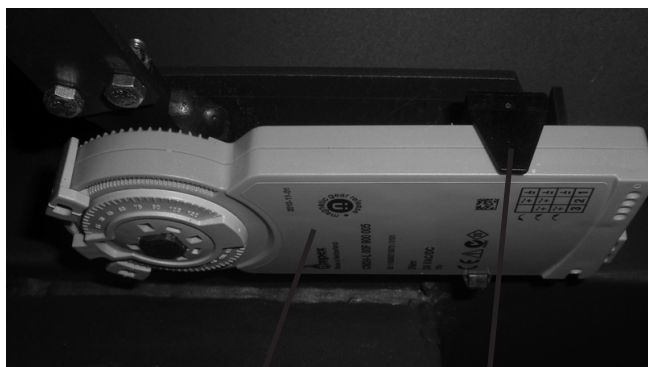
Servomotor Klembeugel van kunststof
