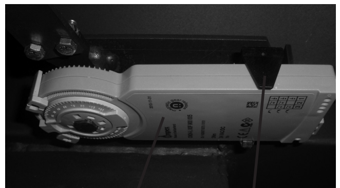
Servomotor Klembeugel van kunststof
