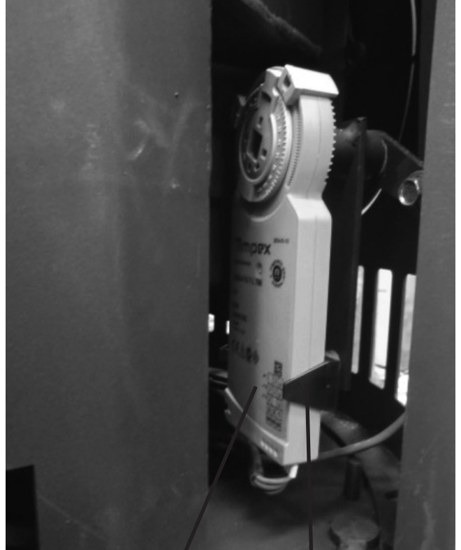
Moteur de commande Patte de maintien moteur
