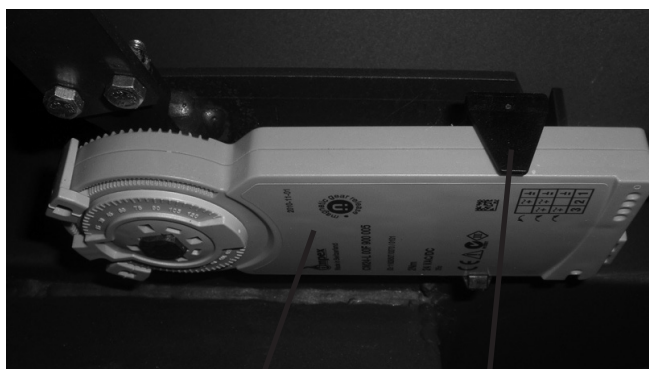
Moteur de commande Patte de maintien moteur
